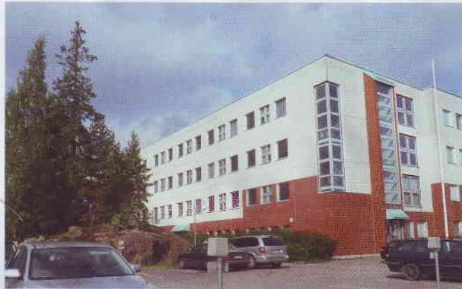
Testwell-Headquarter im finnischen Tampere: im Auftrag von Verifysoft werden hier auch zukünftig Testtools entwickelt und wichtige finnische Großkunden betreut.
